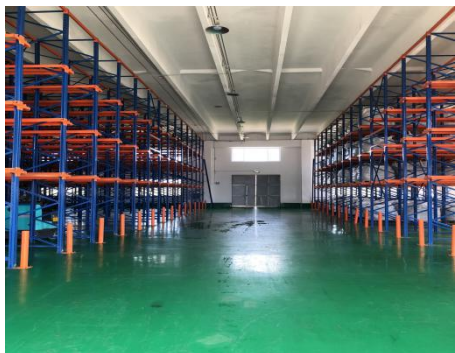
359 危废仓库地面防渗
