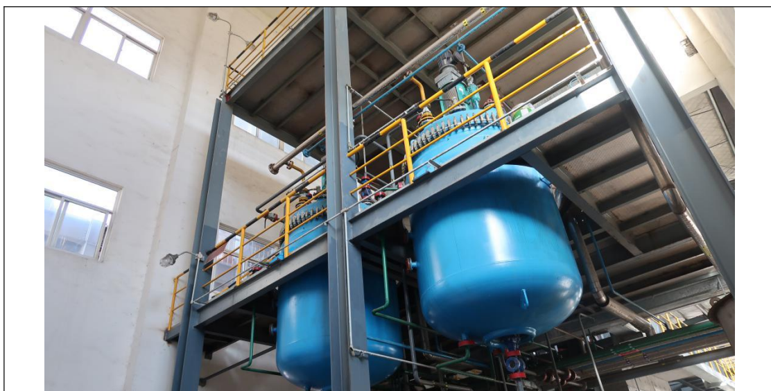
废盐焚烧炉照片
