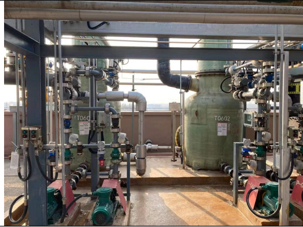
二级碱吸收（三氯吡氧乙酸、三氯吡氧乙酸丁氧基乙酯、350 罐区）
