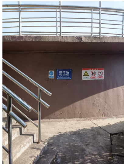
二期生化-混沉池
