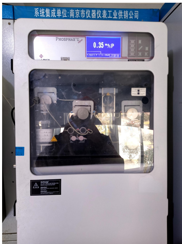
废水总排口-总磷在线
