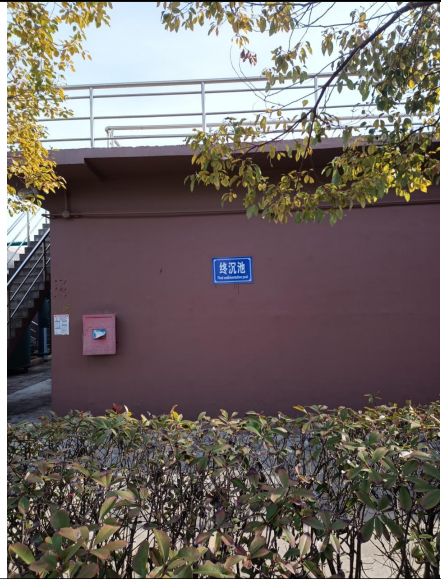
二期生化-终沉池
